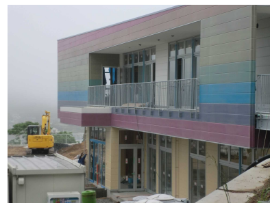
工事中の吉里吉里保育園新園舎
